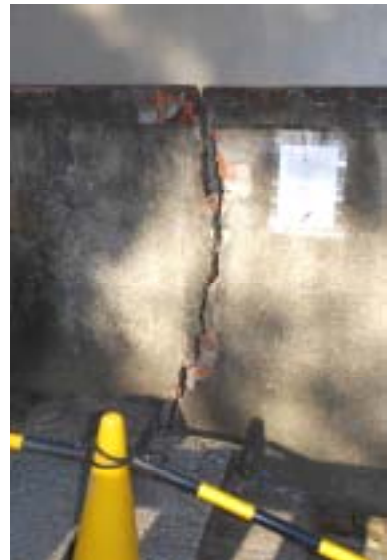
(写真)根津神社のコンクリート製の壁にも大きな亀裂が出来ていました。「危ない」の張り紙がしてあります。
